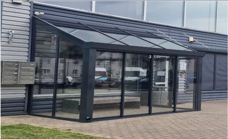
4.pav. Įėjimo tambūras. Pavyzdys su stumdomomis automatinėmis durimis ir judesio davikliais
